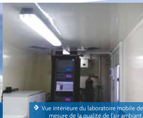
➤ Mesure de la qualité de l'air ambiant aux limites d'une cimenterie.
