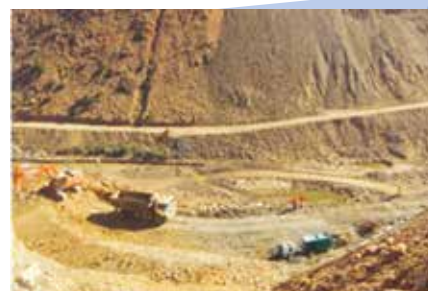
➤ Axe du barrage Tiddas (photo prise à partir de la rive gauche).
